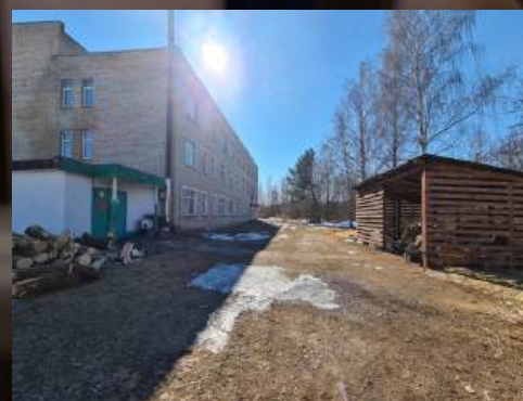
ЗДАНИЕ ПРОИЗВОДСТВЕННО - БЫТОВОГО КОРПУСА
